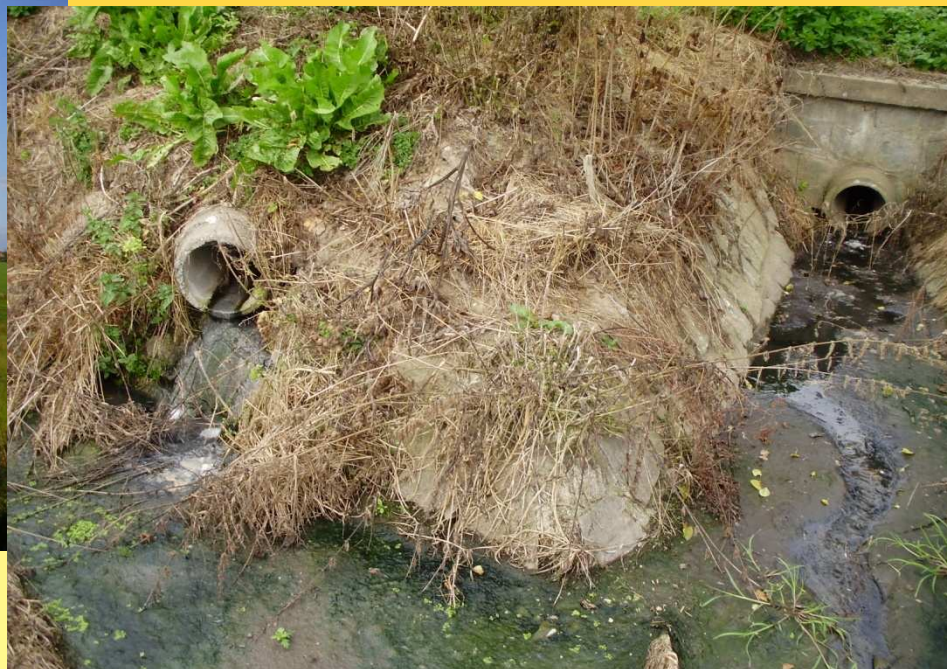
Vyústění kanalizace – obec Velká Chyška
