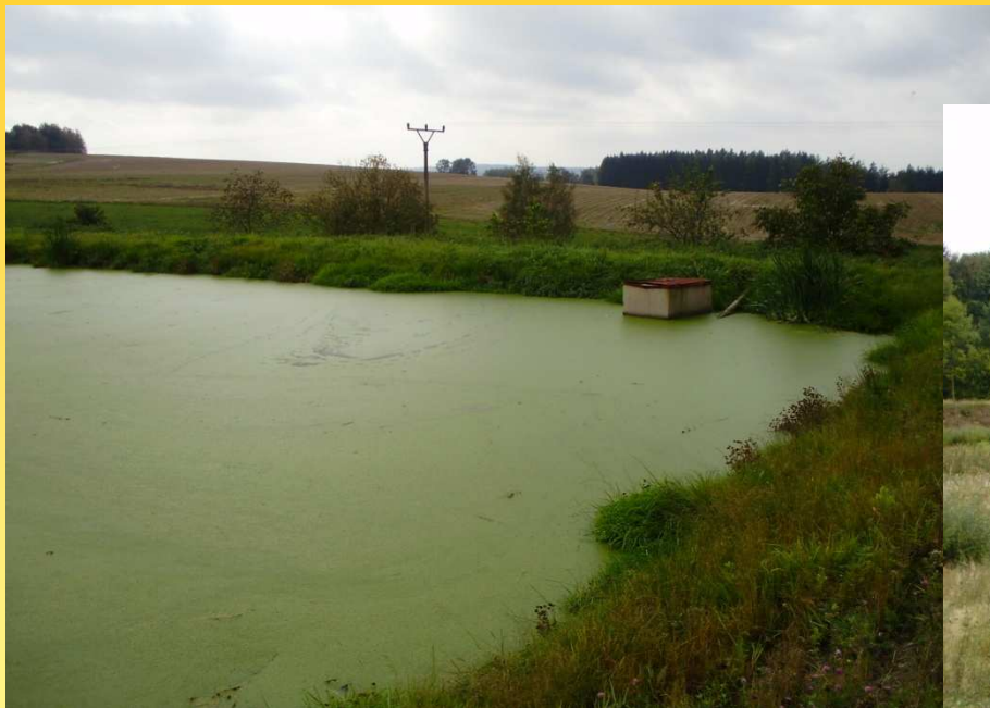
Biologická nádrž – ZD Zhořec
